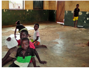
Zyklonschäden im Klassenzimmer
